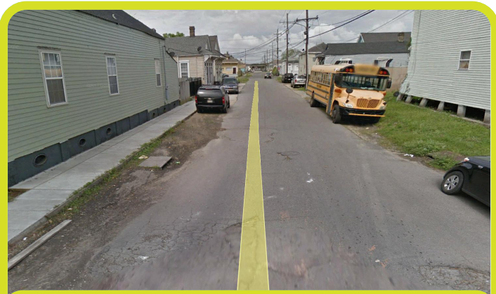
d North Prieur Street Bioswales
