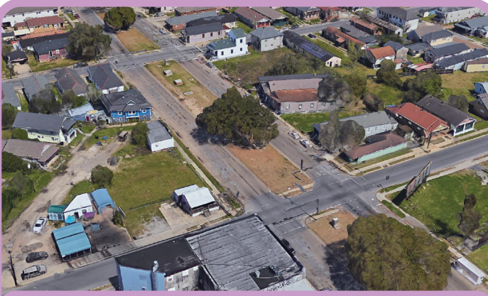
a A.P. Tureaud Avenue Pervious Pavement
